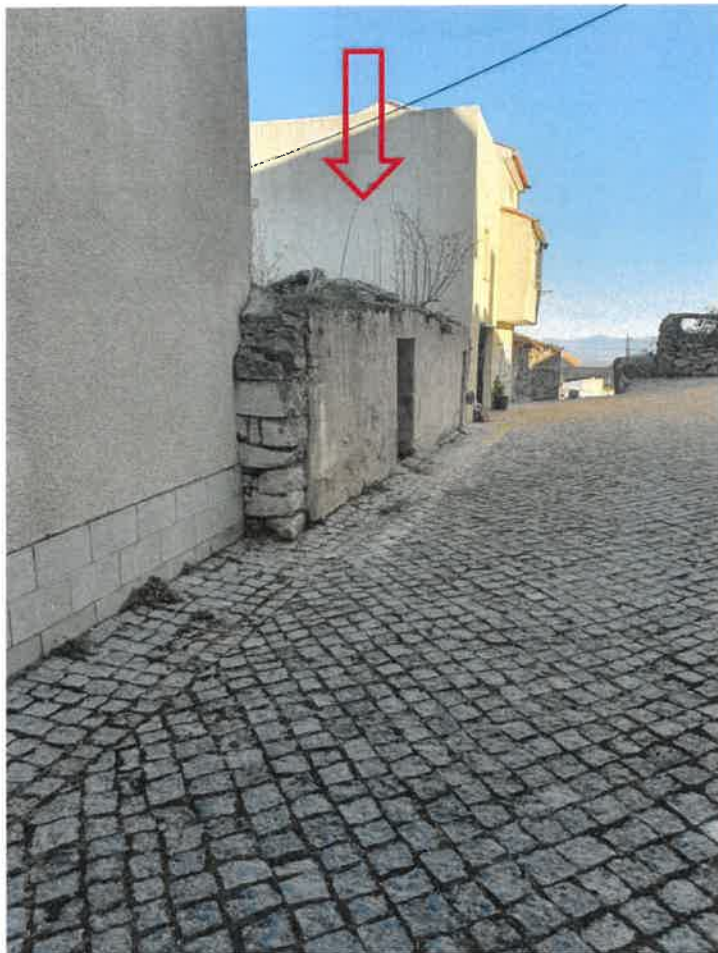
FOTOGRAFIA N.º 01 – ARRUAMENTO – ZONA DE INTERVENÇÃO.
