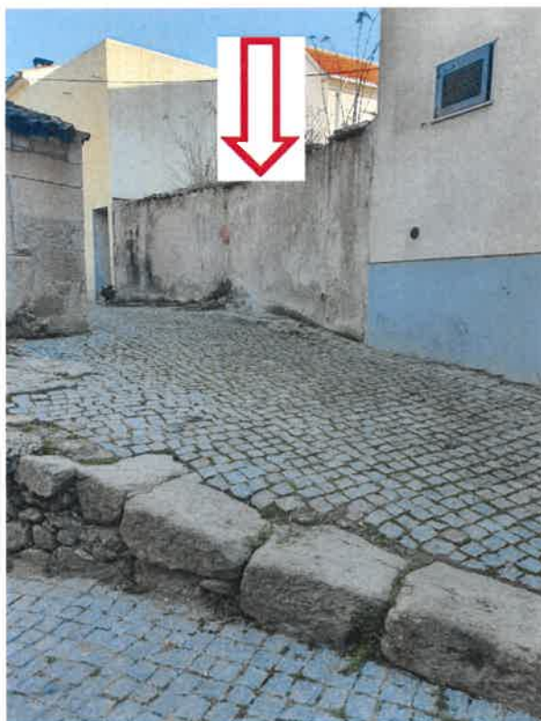
FOTOGRAFIA N.º 02 – EDIFÍCIO EXISTENTE.
