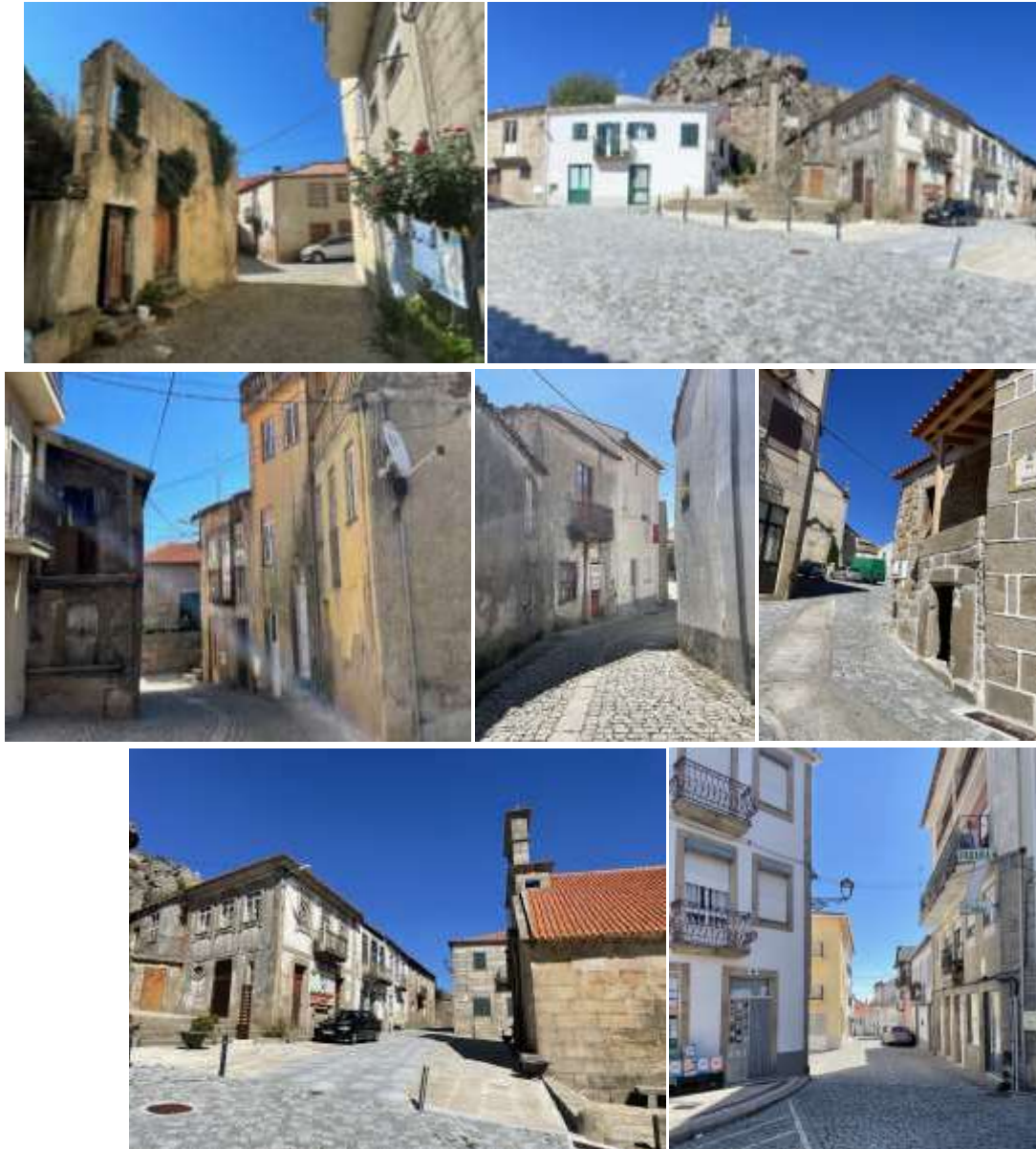
Figura 11. Registo fotográfico do edificado e espaço público da ARU de Mêda – Núcleo antigo
