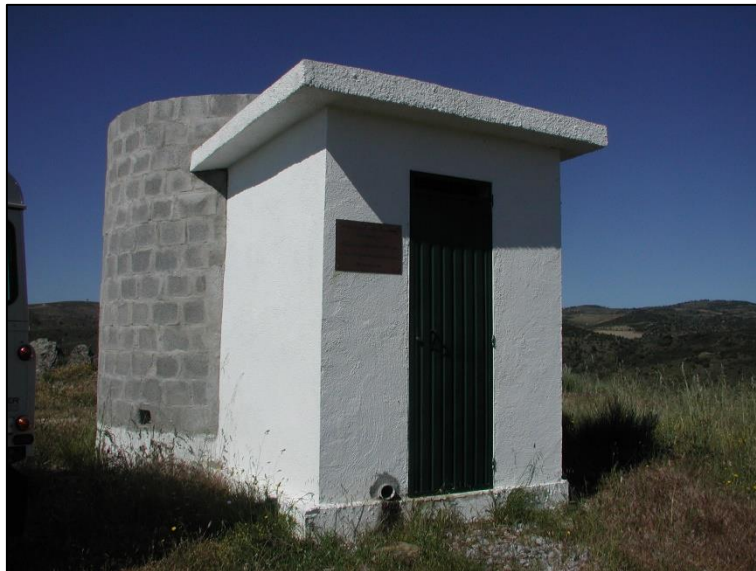
Figura 5 – Reservatório do Vale do Pereiro.
