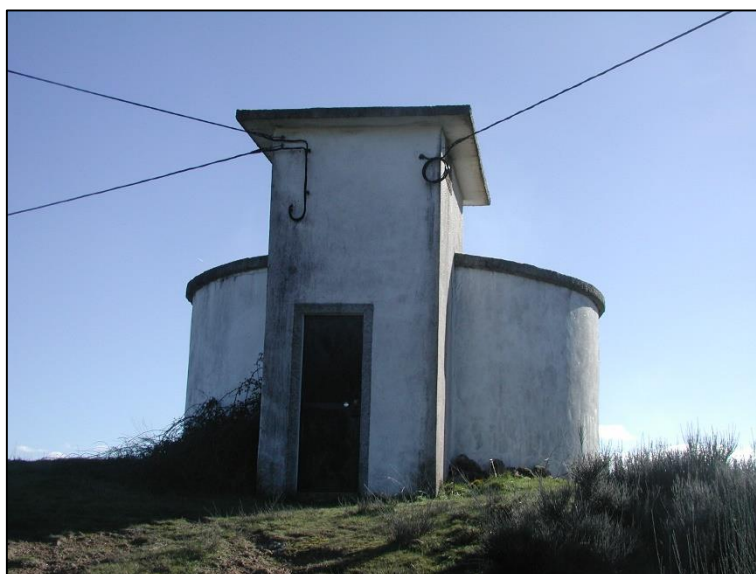
Figura 4 – Reservatório de Alcarva.
